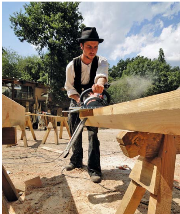
Die Mafell-Kettensäge mit einer Schnitttiefe von 40 cm war für den Abbund ideal Foto: Mafell
