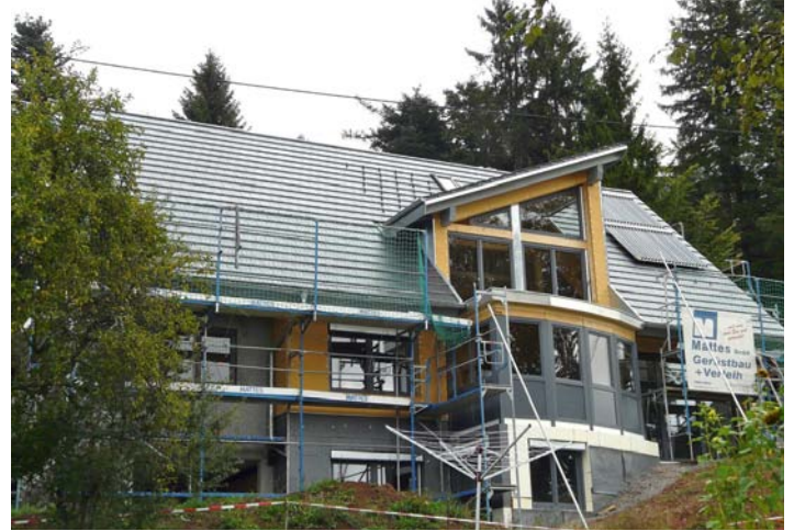
Das Architektenhaus wurde mit Holzfaserdämmung auf Passivhausniveau gebracht Fotos: Gutex Holzfaserplattenwerk/Architekt Lauber
