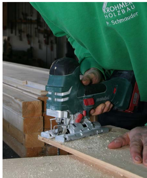
Links: Zuschnitt einer Türzarge mit der kabelgebundenen Stichsäge STE 140 Plus Foto: José Kunze
