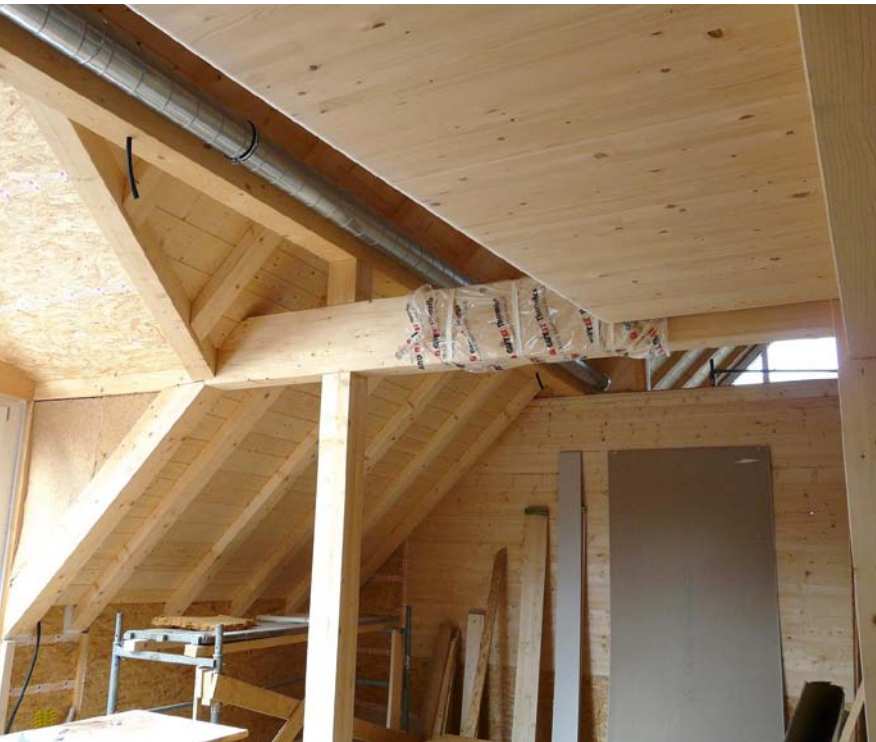
Innenansicht: Man erkennt die filigran gestalteten Sparren mit der zusätzlichen Dämmebene
