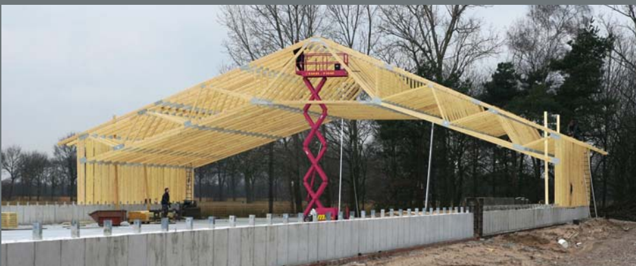
Nagelplattenverbinder werden oft beim Bau von landwirtschaftlichen Gebäuden eingesetzt Foto: GIN/Janssen
