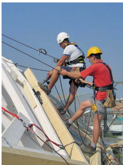
42 Ingenieurholzbau ermöglicht spektakuläre Dachform
