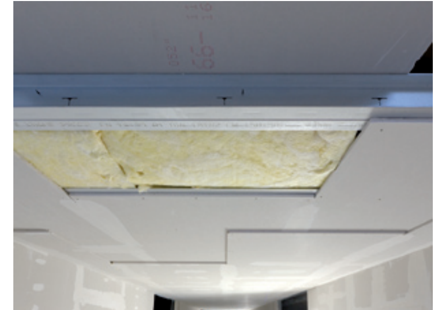
Deckenausbildung mit freigespannten CW-Profilen und F90-Beplankung mit Fireboard
