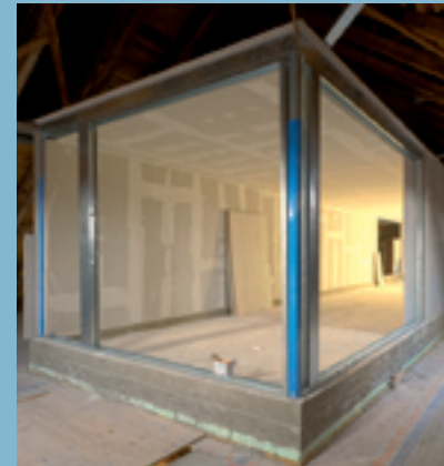
Leichte Bauweise aus Teleskop-Stützen und Standard-Profilen
