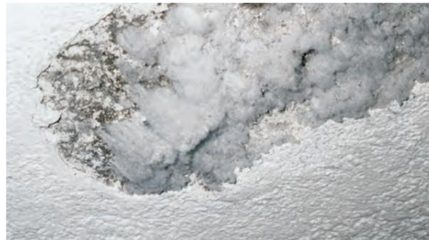
Feuchte- und Salzschiäden. Nach Ursachenbeseitigung Auftrag eines Sanierputzsystems.
