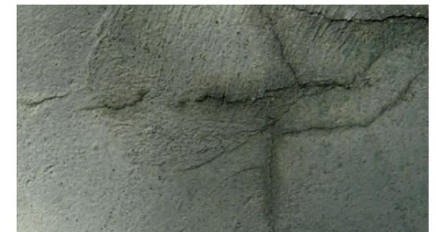
Schwind- und Sackrisse, die schon unmittelbar nach Aufbringen der Putzschicht entstanden sind. Die große Rissbreite erfordert eine putztechnische Sanierung.
