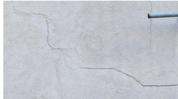
Stoß- und Lagerfugenrisse, untergrundbedingt. Sanierung vorzugsweise durch WDVS, bei statischer Beeinträchtigung Rissverpressung.
