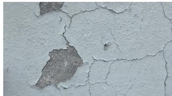
Abblätternde Beschichtung. Sanierung durch vollständiges Abtragen, Grundieren und Neu-Beschichten.
