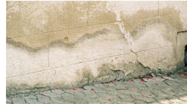
Aufsteigende Feuchtigkeit aus dem erdberührten Bereich, verstärkt durch Spritzwasser. Sanierung durch nachträgliche vertikale oder horizontale Abdichtung und verbesserten konstruktiven Nässechutz.
