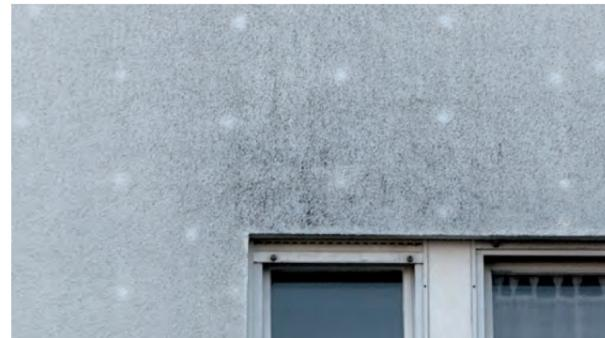
Befall durch Algen auf WDVS, auffällig die unterschiedlichen Wachstumsbedingungen durch abweichende thermische Eigenschaften der Dübel. Sanierung durch biozide Beschichtung.
