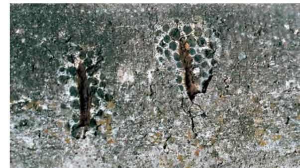
Betonschäden durch Carbonatisierung, Bewehrungskorrosion und eindringendes Wasser. Sanierung durch Korrosionsschutz, Reprofilierung und Oberflächenbeschichtung.
