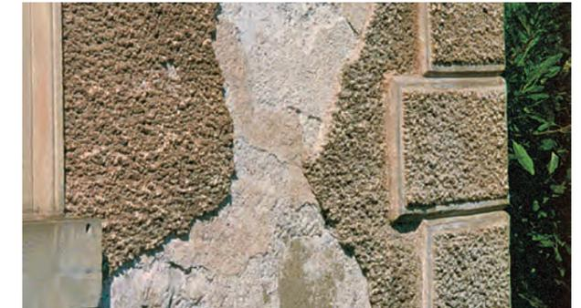
Putzabplatzung auf Mischmauerwerk mit unterschiedlichem Dehnverhalten. Sanierung mit einem armierten Putzsystem.
