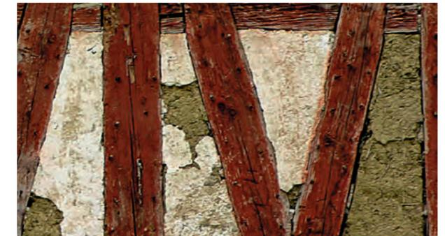
Verwitterte und ausbrechende Verfüllung einer Flechtwerk-Ausfachung. Sanieren durch Instandsetzung des Flechtwerks und Neu-Verputzen.
