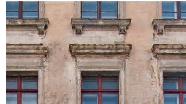
Ausbrechender oder fehlender Stuck. Restaurierung oder Wiederherstellung im ein- oder zweistufigen Wandzug, alternativ im Tischzug.
