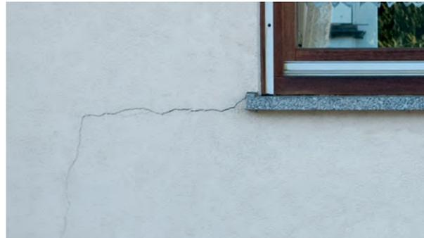
Untergrundbedingte Risse. Einzelrissanierung mit/ohne putztechnische Flächenanierung.
