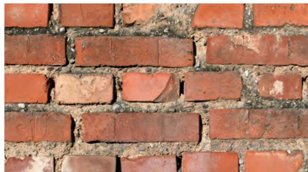
Ausgewitterte und sandende Fugen. Sanierung durch Auskratzen und Neu-Verfugen.
