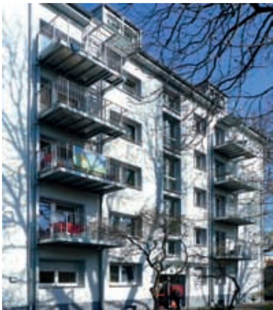
Frankfurt/Main, Alfred-Brehm-Platz Energetische Modernisierung, 1950er Jahre Bauherr: Ruth Thon, München Planung: Dannehl Architekten, BDA, Heusenstamm
