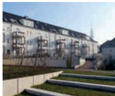
Verbindende Wegführungen durch eine großzügige Freitreppe
