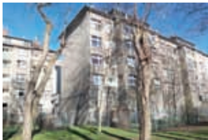
Bestand vor der Sanierung
