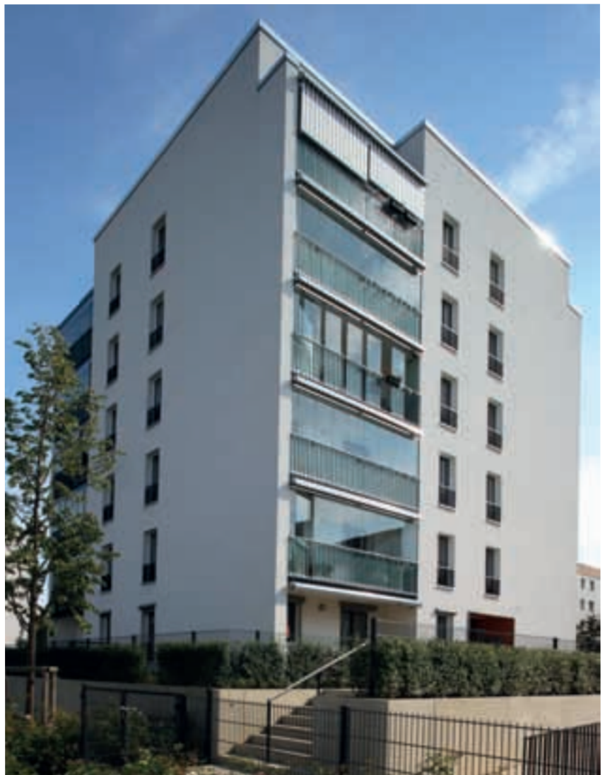
Für die barrierefreie Erschließung der Erdgeschossenebene und die Zuordnung von Terrassen und kleinen Mietergärten wurde das Gelände angefüllt und mit Stützmauern abgegrenzt.
