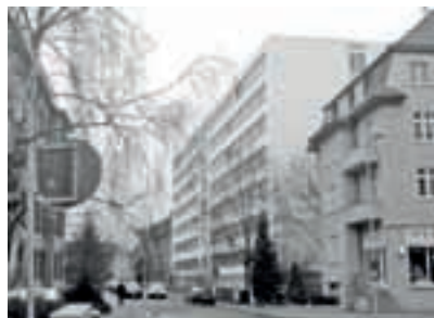
Skelettbau aus den 1970er Jahren
