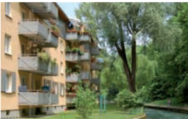
München, Am Paulanerplatz Modernisierung Wohnanlage, 1950er Jahre Bauherr: GWG Städtische Wohnungsgesellschaft München mbH Planung: ABS. Architekturbüro Stocker, München
