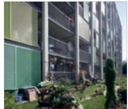
Die bestehenden Loggien wurden entfernt und durch großzügige Balkone ersetzt.
