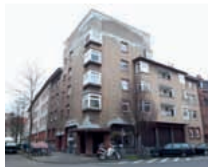
2006: stark sanierungsbedürftig; Beginn der tiefgreifenden Erneuerung
