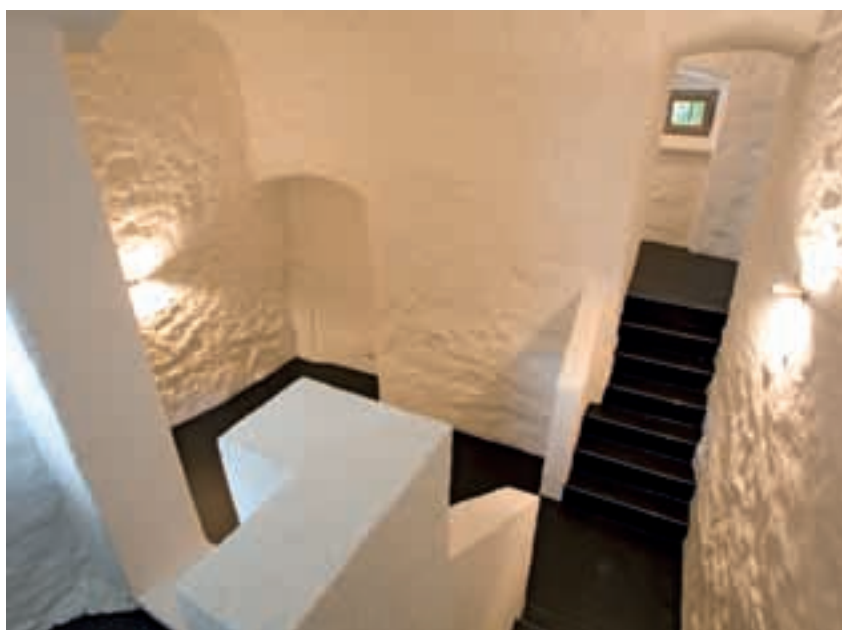
Die vorhandenen Bruchsteinwände wurden mit einer dünnen Kalkschlämme überzogen; ein über alle Geschosse schwarzer Linoleumboden unterstützt die historische Substanz.
