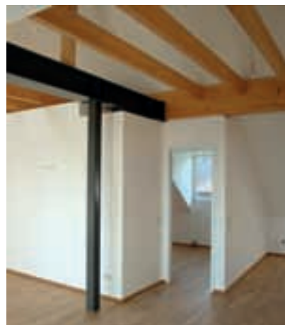
Die bisher als Trockenräume genutzten Dachgeschosse werden ausgebaut.
