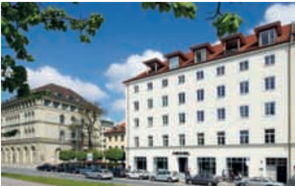
München, Von-der-Tann-Straße Denkmalgeschütztes Ensemble, 1950er Jahre Bauherr: GBWAG v.d. GBW Management GmbH, München Planung: Kaufmann Architekten, München
