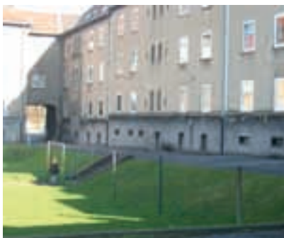
Vor Maßnahmebeginn: Leerstandsquote 30 Prozent der Wohnungen
