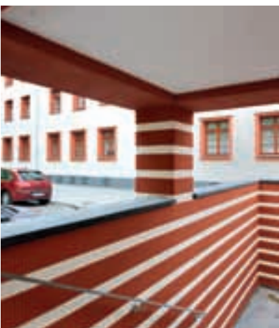
Denkmalgerechte Wiederherstellung des äußeren Bildes und moderner Wohnkomfort
