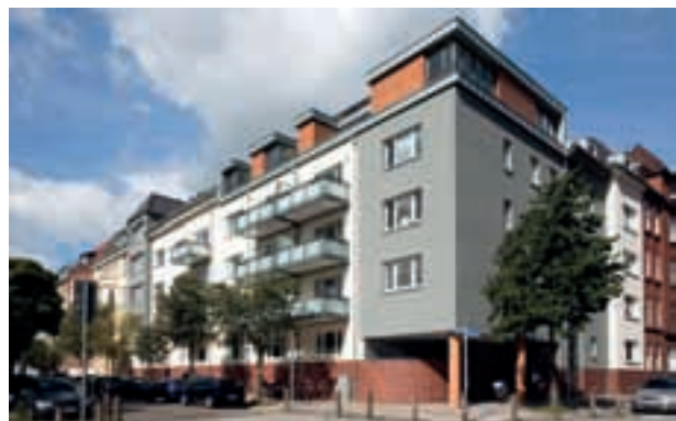
Kiel, Zastrowstraße Modernisierung und Umbau Wohnsubstanz 1950er Jahre Bauherr: WOGÉ Wohnungs-Genossenschaft Kiel eG Planung: Bock, Schulz und Partner, Architekten BDA, Kiel
