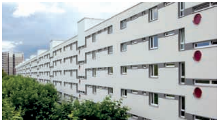
DENA-Modellvorhaben: weitgehende „warmmietenneutrale“ Komplettsanierung mit einer Qualität von 70 Prozent Neubaustandard EnEV 2009.
