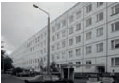
Straßenansicht vor der Modernisierung
