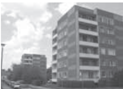
Bestandsgebäude vor der Sanierung
