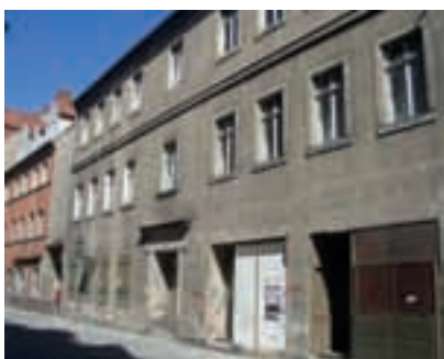
Umnutzung einer Bauruine zu einem internationalen Bildungsstandort
