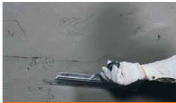
Ausgleich von Unebenheiten mit Dichtputz PCI Saniment® DP
