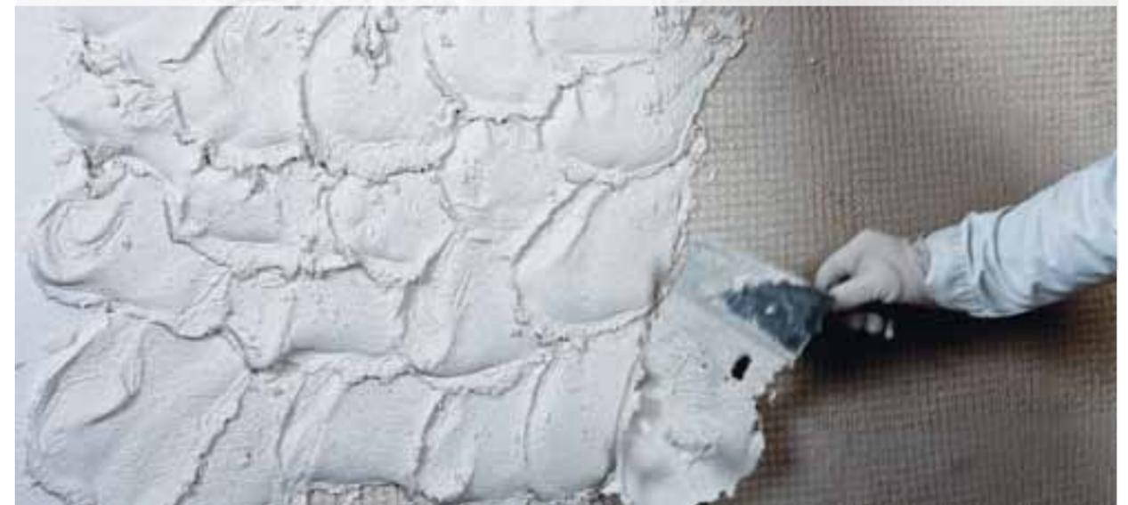
Zweilagige Verarbeitung des Sanierputzes PCI Saniment® Classic: Vor dem Aufbringen der zweiten Schicht Sanierputz muss die erste Schicht aufgeraut werden.
