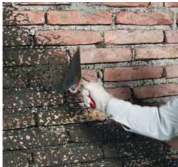
Netz förmiges Anwerfen von Spritzbewurf PCI Saniment® HA mit der Dreieckskeile
