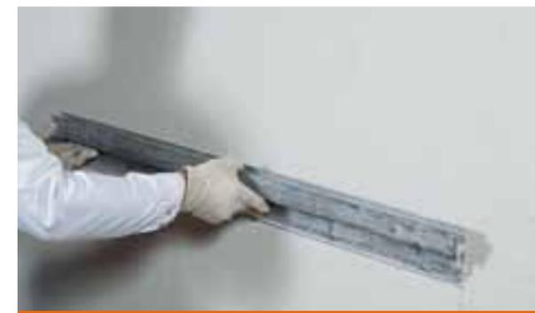
Einlagige Verarbeitung des sulfatbeständigen Sanierputzes PCI Saniment® Super
