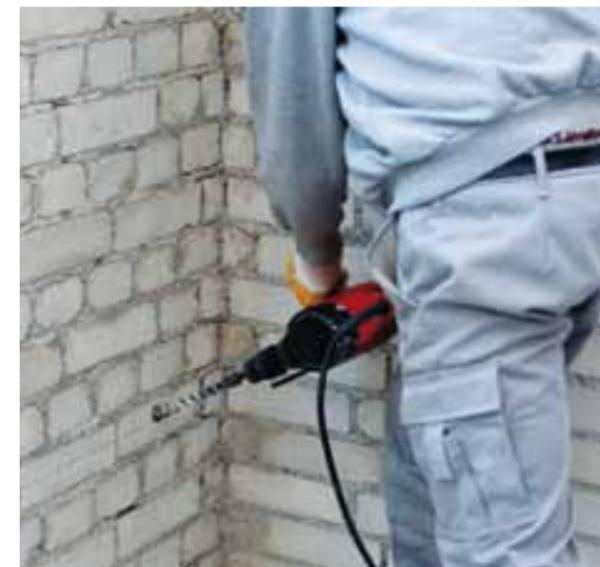
Vorbereitung der Bohrlöcher zum Herstellen einer Horizontalabdichtung
