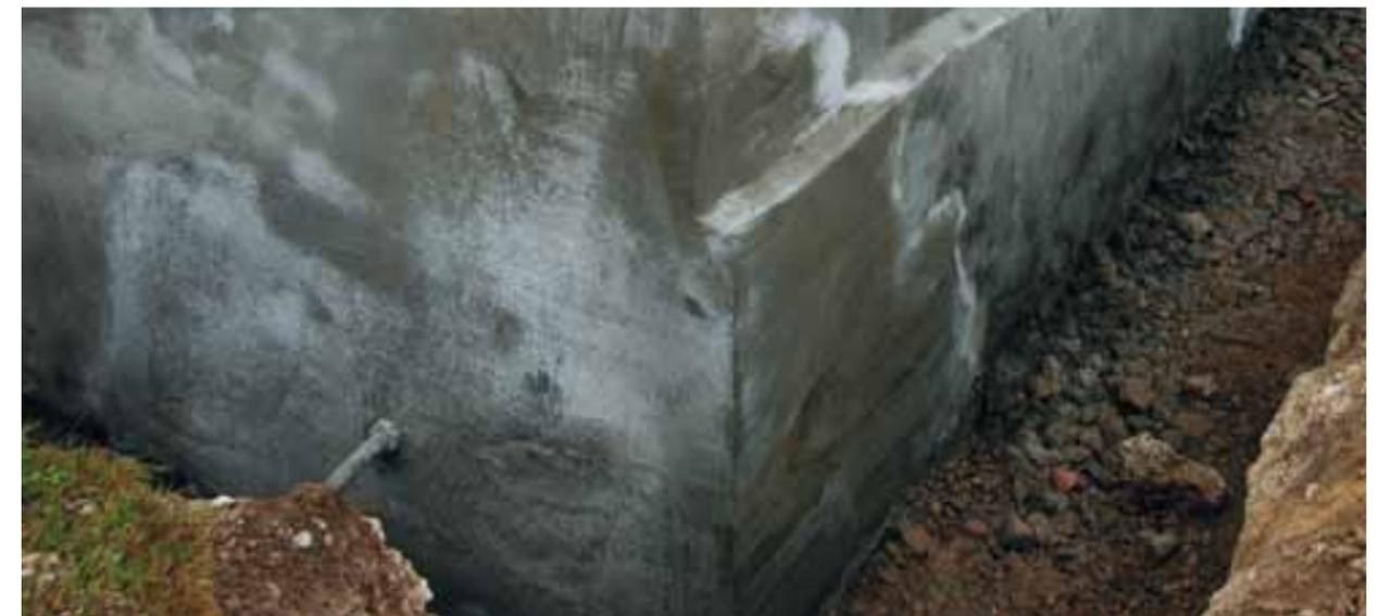
Freigelegte und ausgeglichene Kelleraußenwand vor der Durchführung einer flächigen Kelleraußenabdichtung
