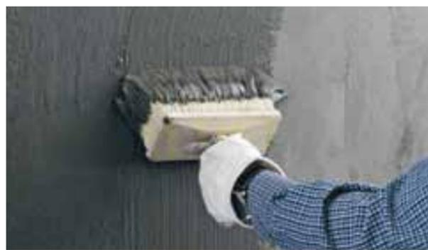
Abdichtung gegen eindringende Feuchtigkeit mit Dichtschlämme PCI Saniment® DS
