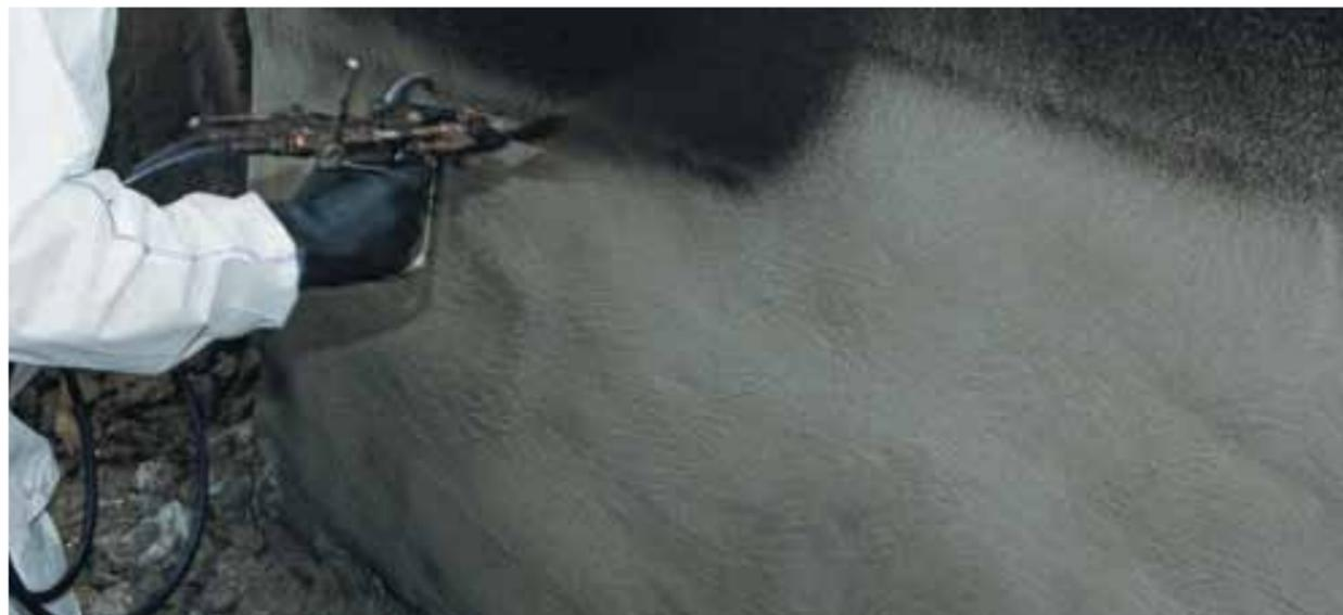
Grundierung der Kelleraußenwand mit PCI Pecimor® F vor der Abdichtung mit der Bitumen-Dickbeschichtung
