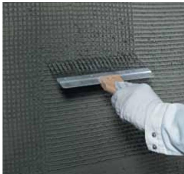
Aufrauen des Dichtputzes PCI Saniment® DP mit dem Putzkamm vor dem Aufbringen des Sanierputzes
