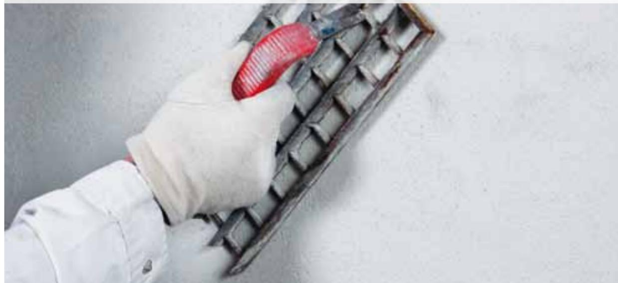
Rabotieren der Sanierputzoberfläche aus PCI Saniment® Super mit dem Gitterrabbott vor dem Aufbringen des Feinputzes PCI Saniment® FP
