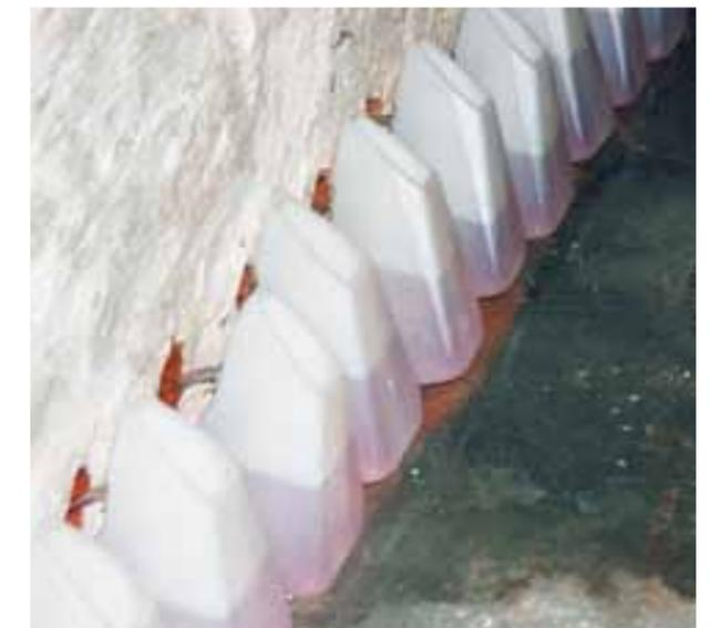
Herstellen einer Horizontalabdichtung durch drucklose Injektion mit PCI Bohrlochsperr
