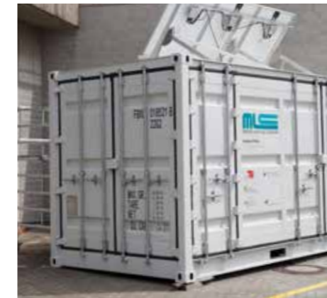
Photovoltaik-Zellen mit Akkus gewährleisten eine autarke Stromversorgung.
