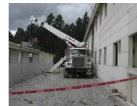
Die Unterkünfte für die Minenarbeiter werden mit Hebel gebaut.
